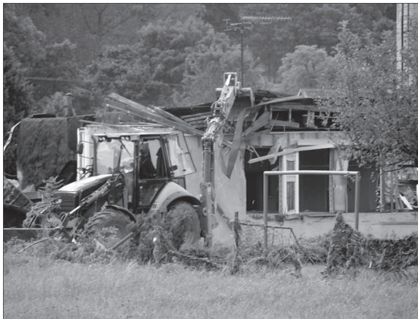
Demolice knihovny v Raspenavě.
