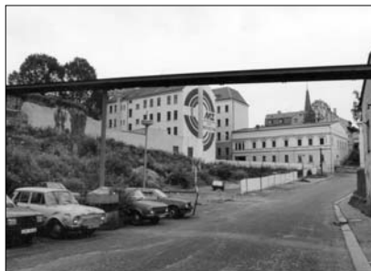
Před zahájením stavby 1996 (Pastýrská ulice)
