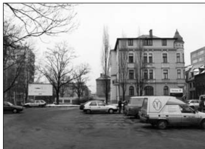
Před zahájením stavby 1996 (Rumjancevova ulice)
