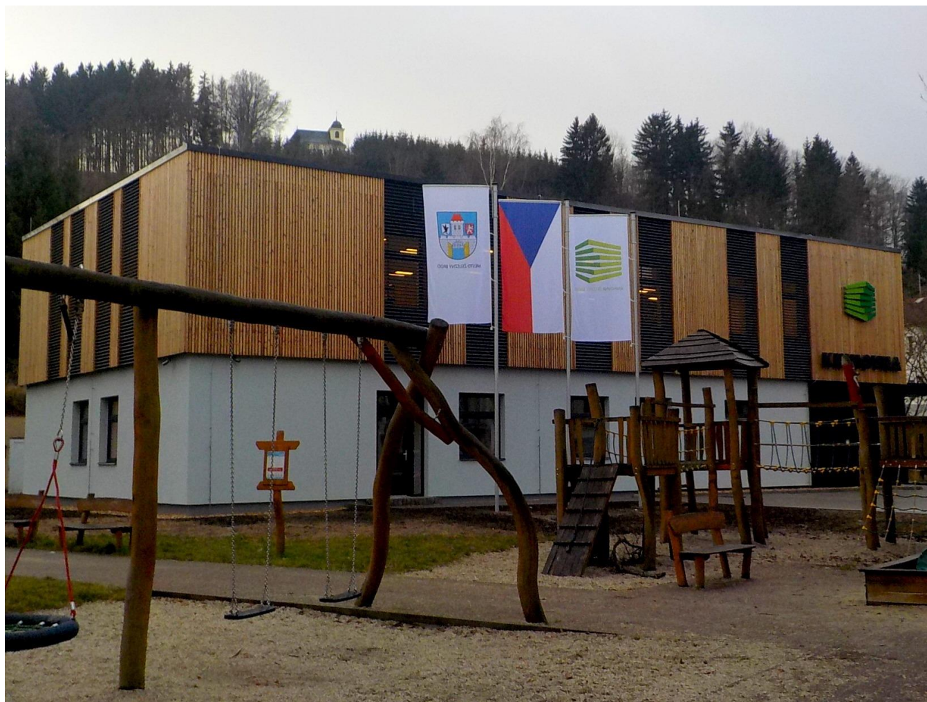
Nová budova knihovny v Železném Brodě
