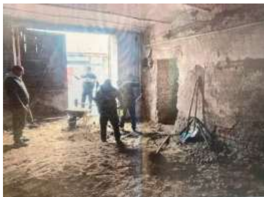
Původní prostor garáže
